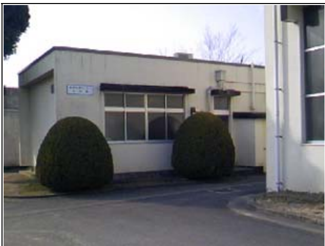
センタースタッフの詰め所である排水処理センター管理棟
