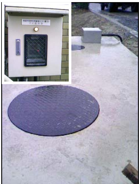
移設された教育学部の実験排水枡。 pH 指示計は以前と同じ場所にある
