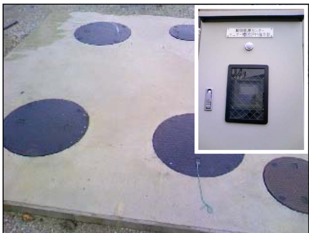
新設された動物医療センターの実験排水枡と pH 指示計
