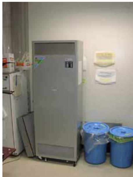
図5 光触媒方式の空気清浄装置
