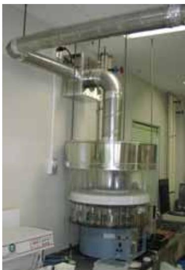
図8 自動包埋装置の換気設備
