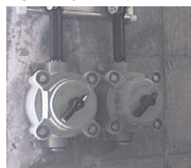
図2 奥側の保管場所
