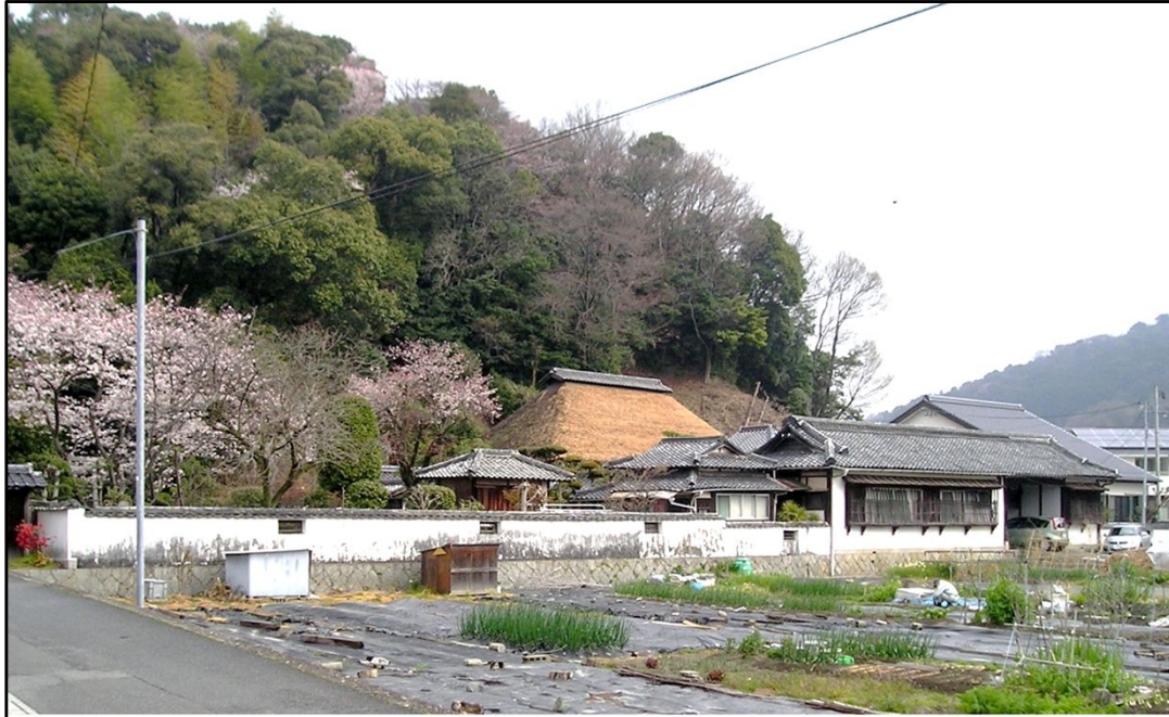
周防富田土井 四熊家 (2013.3.28.撮影)
