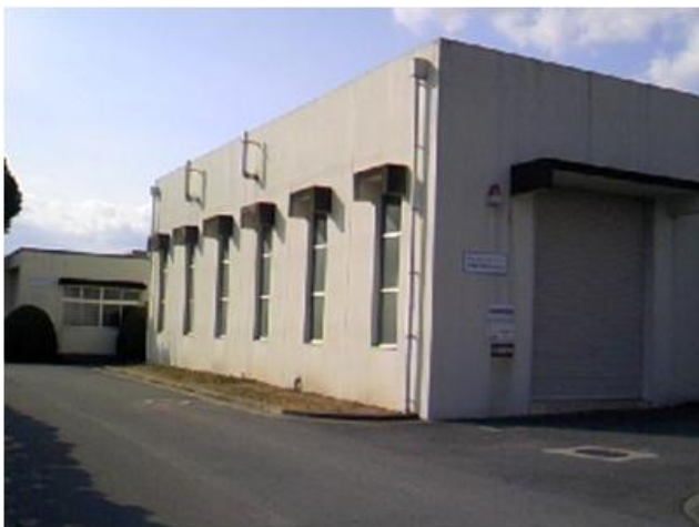
排水処理センター 無機系廃液処理施設(手前)と管理棟(奥)
