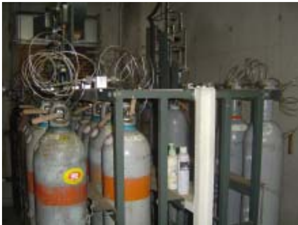
写真7. 集中配管方式
