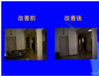
図1 防火扉、シャッター前
